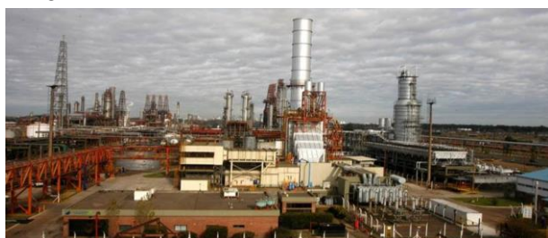
La Plata Cogeneración
